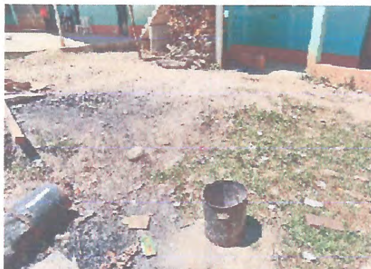
Foto 2: MANTENIMIENTO DE LOSA DE PATIO
